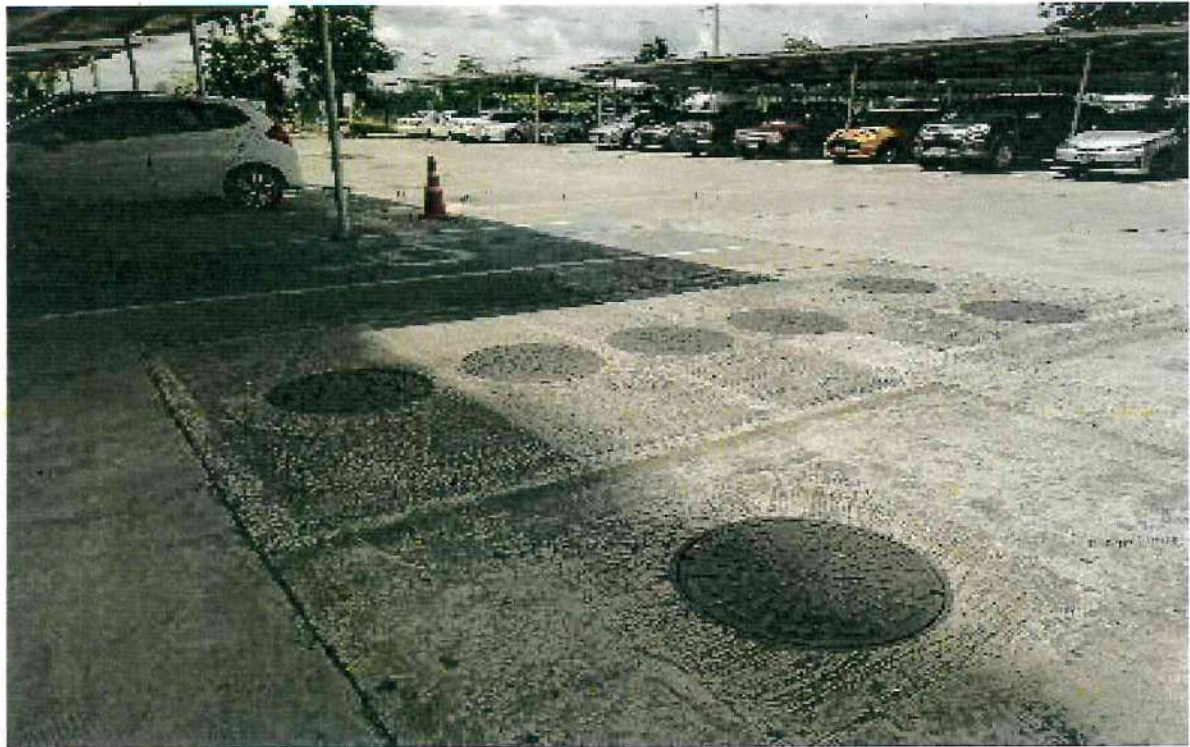
รูปที่ 74 โครงการจัดให้มีระบบบำบัดน้ำเสียชนิดเดิมอากาศแบบมีตัวกลางยัดเกาะ รองรับน้ำเสียได้ 160 ลบ.ม./วัน จำนวน 1 ชุด ติดตั้งไว้ด้านหลังอาคารโรงพยาบาล
